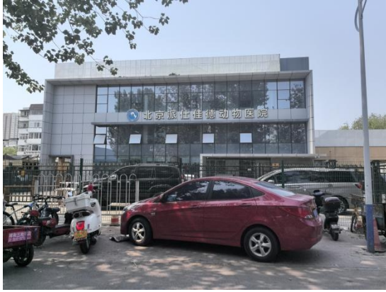
照片 2-1 5号建设用地北侧建筑
